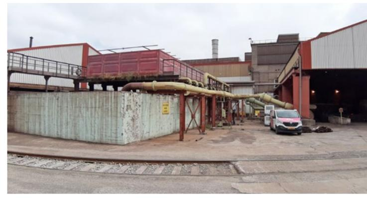
Industeam Luxembourg s'est vu confier un chantier de remplacement de l'ensemble des tours réfrigérantes (4) sur le circuit QST – refroidissement des eaux de traitement thermique des poutrelles en sortie de laminage.
